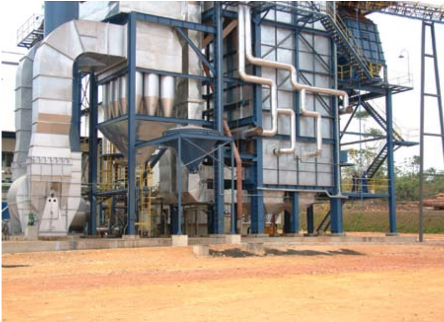
Een elektriciteitscentrale in Brazilië die gestookt wordt op afvalhout voorziet een dorp met 40.000 inwoners van electriciteit .
