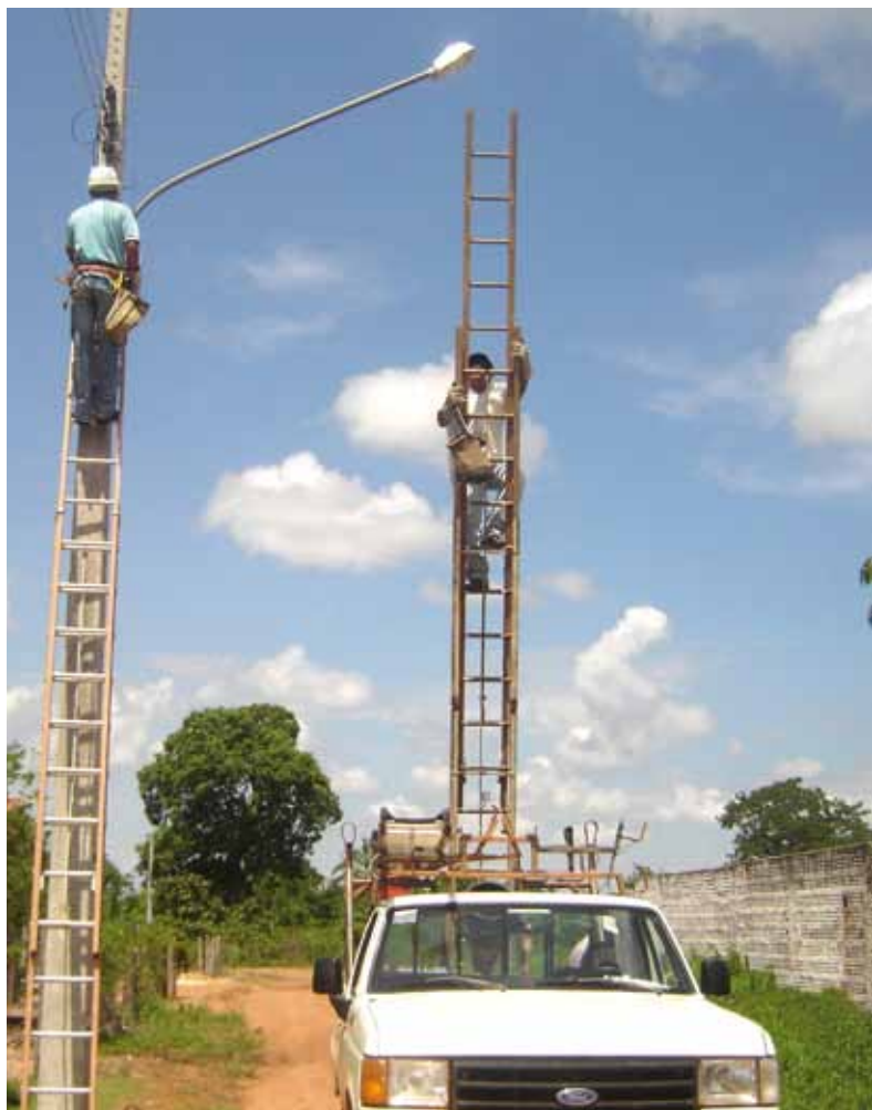
De straatlampen in het dorpje Clarinópolis worden na maandenlange duisternis vervangen doordat Floresteca Foundation te hulp schoot.
